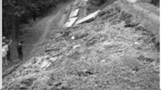
圖十 原有路基下陷滑移
