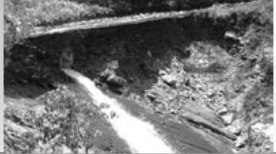
圖二 3K+750路基淘空岩盤裸露
