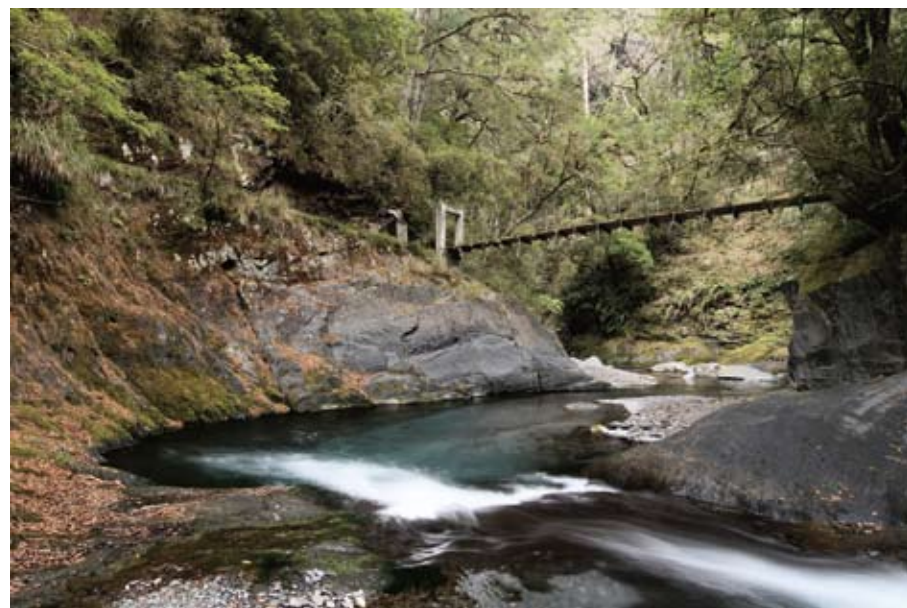
畢祿溪一號吊橋 Piluchi No. 1 Suspension Bridge 古樸的吊橋跨越在深峻的溪谷上，別有一番尋幽探秘的美感。 (劉光智 攝)
