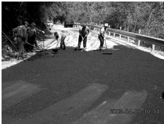
【5】鋪設瀝青混凝土 【5】Paving asphalt concrete
