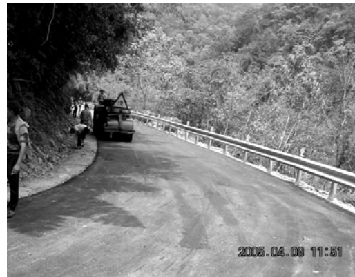
【6】瀝青混凝土路面滾壓 【6】Rolling asphalt concrete
