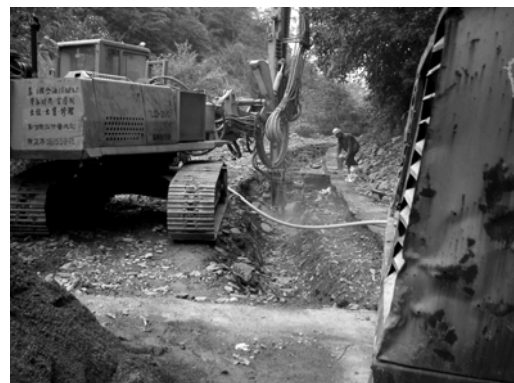
【2】 內土釘位置鑽孔
