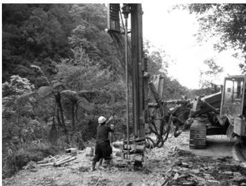
【1】 外土釘位置鑽孔
