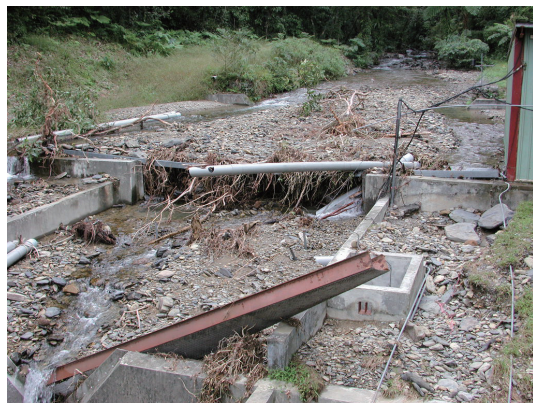
颱風後的福山二號試驗集水區，原來的設施全毀。 (李福明攝)
