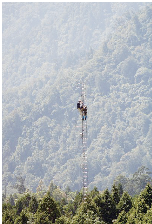
棲蘭山通量量測塔，這是森林微氣象研究標準的設施，以監測樹冠層頂的氣象。圖中是夏禹九和碩班生樁侯森正在裝設儀器。
