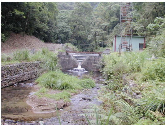
福山二號試驗集水區量水堰。
