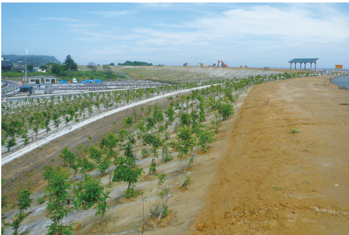
福島縣廣野町海岸防災林基地整備工事。
