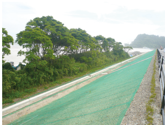
福島縣廣野町盛土工邊坡護網。
