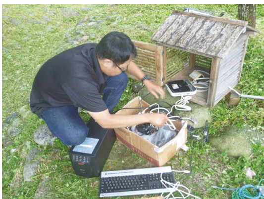
圖2 錄音設備除了麥克風外，我們將擴大器、小電腦及不斷電系統與有線電源等，都放進百葉箱或不鏽鋼設備箱中。(林文智 攝)
