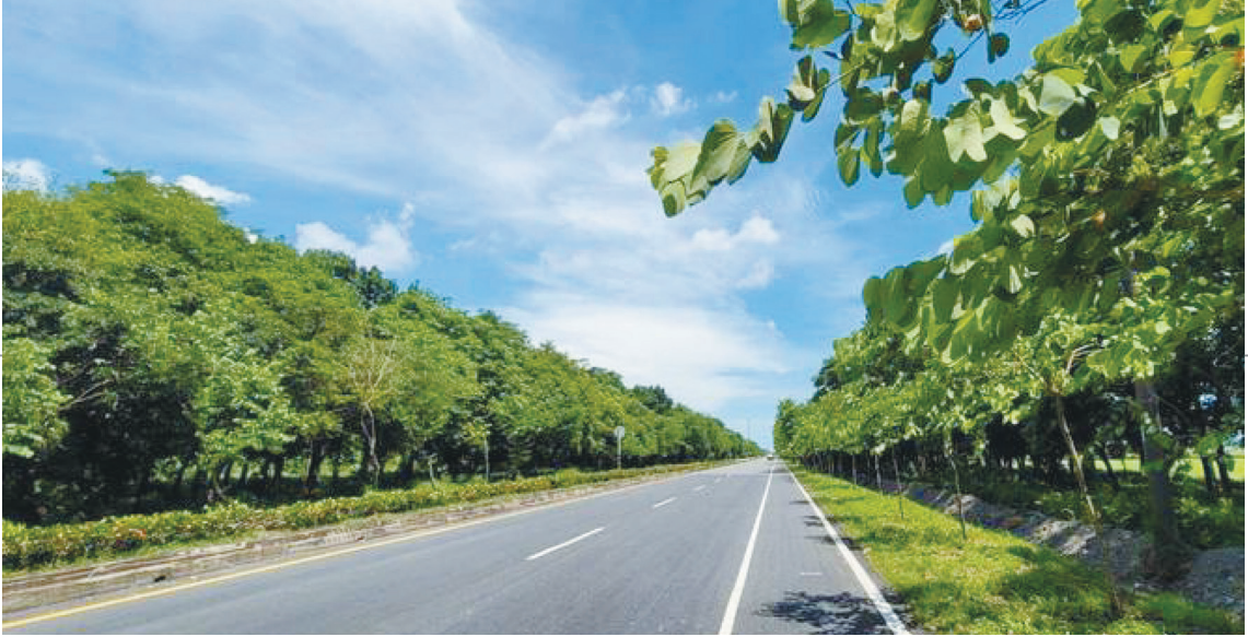
圖2 屏鵝公路樣子腳路段(全國種樹諮詢中心提供)
