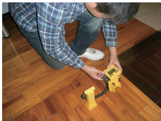
圖4 利用微波白蟻偵測儀檢測木地板白蟻危害(蔡君璋 攝)
