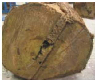
圖2. 杉木(腐朽)影像圖(李銘鐘 製圖)
