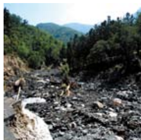
1號橋全毀，平均溪寬60~80 m
