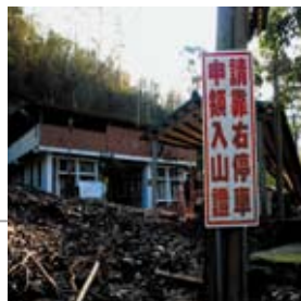
3.4 K檢查哨前被土石流掩蓋
