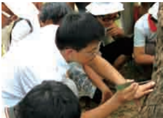
圖2 檢視發現白蟻入侵蛀食危害老樟樹(李政盟 攝)
