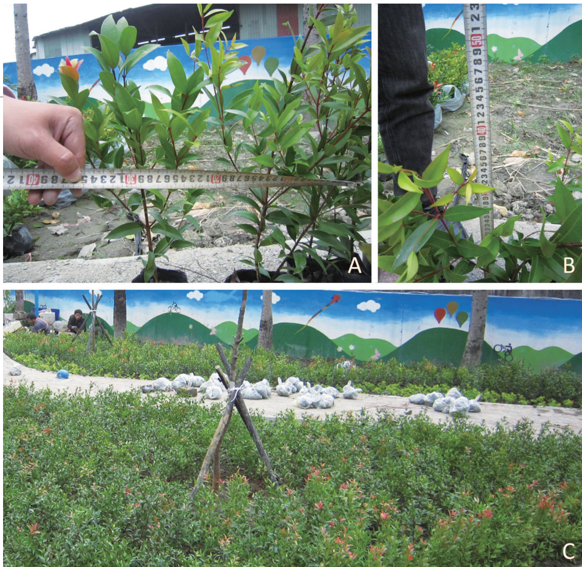
圖2 材料集運至施工現場，栽植前需抽驗苗木是否達到契約規定及要求，施工完畢後需將廢棄物妥善處理(A.檢驗寬幅；B.檢驗苗高；C.符合規定後施工完成)。
