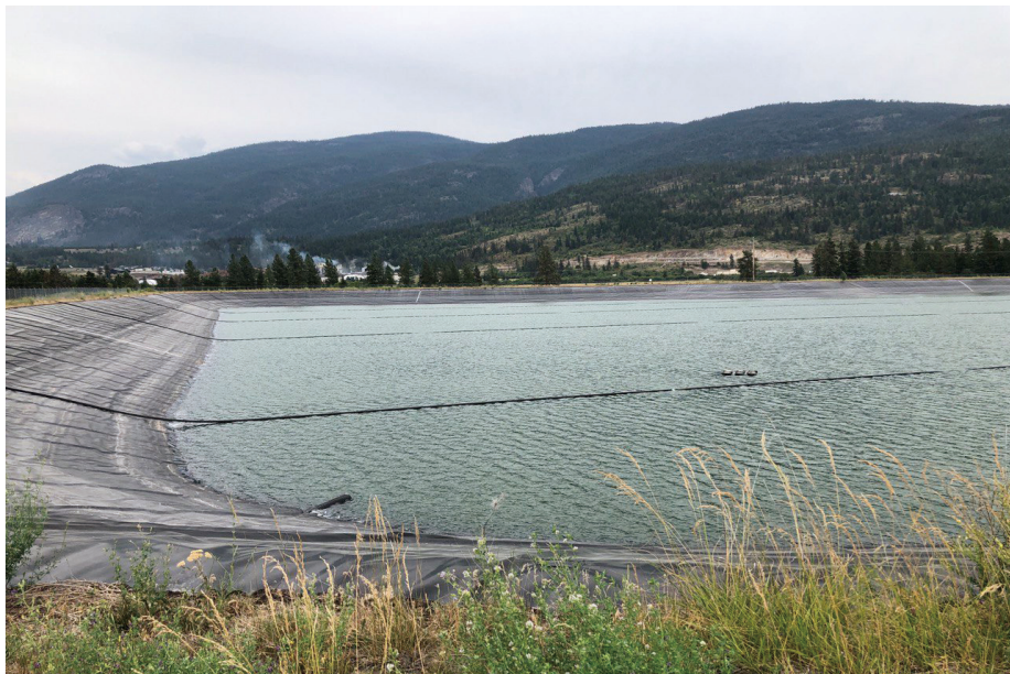
圖2 位於加拿大卑詩省Spallumcheen鎮，匯聚阿姆斯特壯市所產生民生廢水的污水蓄積池 (effluent lagoon) (林冠穎 攝)
