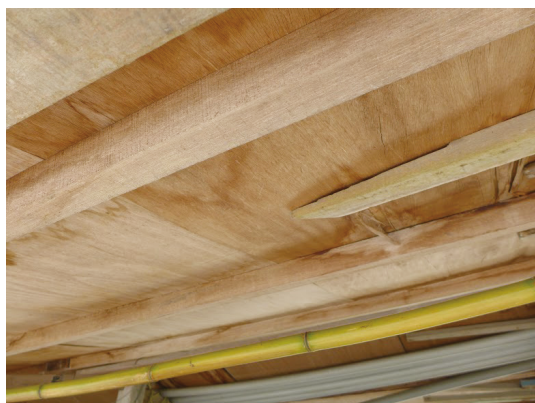
耆老現居家屋旁儲藏室的屋頂橫樑結構。此一結構與採用赤楊木材為傳統屋的橫樑結構類似。(王相華 攝)
