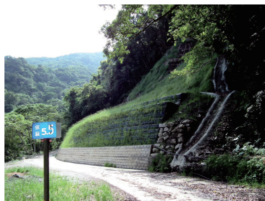
太麻里加勁擋土牆(攝於20140902)
