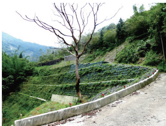
鳳崗南鳳林道交叉口之加勁擋土牆(攝於20120705)
