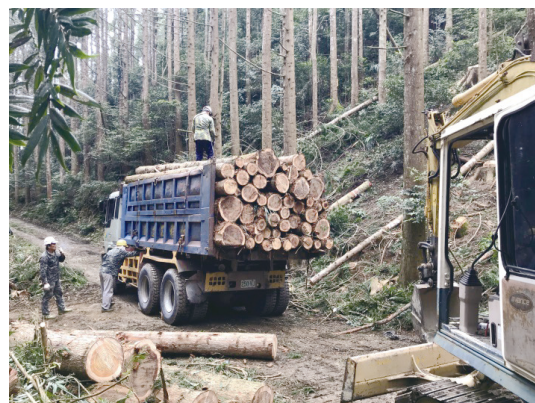
圖4 疏伐現場木材集運裝卸載。
