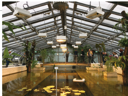
圖5 王蓮展示廳修復後現況。
