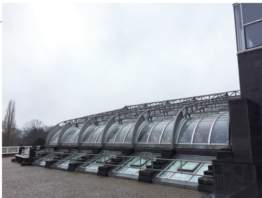
圖4 王蓮館外掛式鋼鐵結構。
