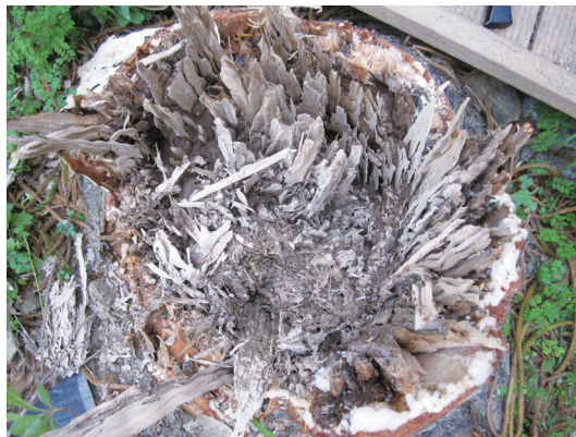
圖5 倒塌的南洋杉基部可鑑定是否為家白蟻所造成 (汪澤宏 攝)
