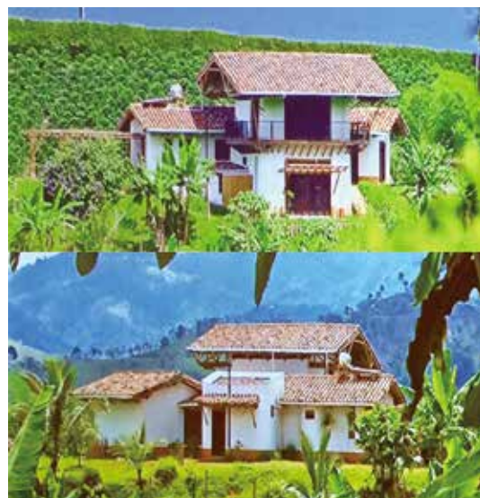
兩層樓的竹建築具有優良的通風系統，即使外面溫度高達40°C，屋內仍保持24°C的涼爽。上圖為正面，下圖為背面(剛特·鮑利 提供)
