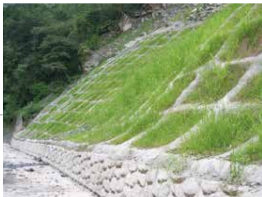
坡面植生是坡面保護工程之一，可兼具綠美化效果。 (林照松 攝)
