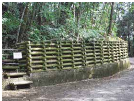
以原木構築的擋土牆可有效降低牆後方的孔隙水壓，並能收就地取材的優點。(陸象豫 攝)
