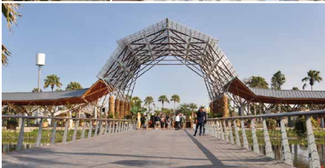
入口棚架施工過程(大藏聯合建築師事務所 提供)
