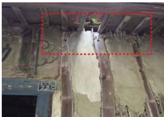
圖7 楹仔若未符合高度則必須在柱仔及楹仔下方使用竹片墊高，並以藤條(右圖：南投鹿谷，2003年)或鐵絲(左圖：高雄橋頭，2000年)綁繫固定(林宜君 攝)
