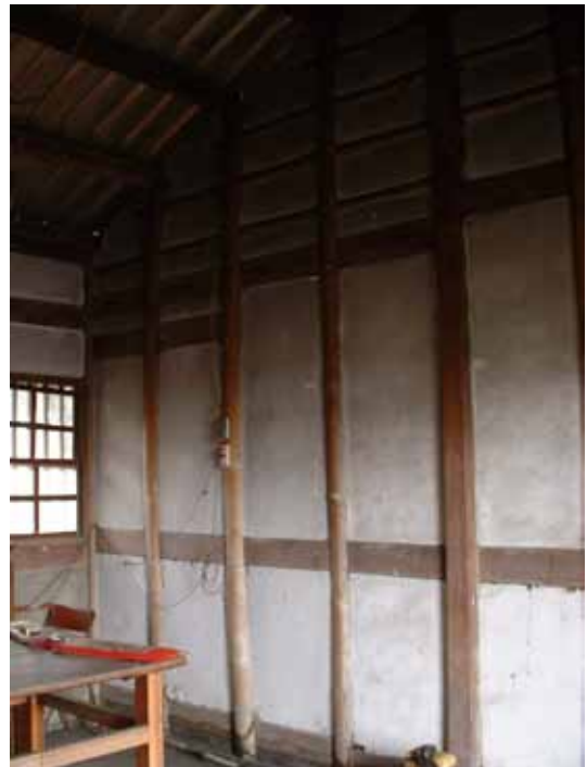
圖5 中柱、角柱、屐、下腰穿、下腳穿等主要構件因結構考量以木料取代，演進為竹木構架作法(林宜君 攝)
