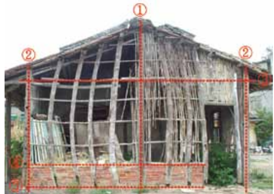
圖4 竹構架作法之穿鬮式構架主要構件(圖例說明：①中柱、②角柱、③屐、④下腰穿、⑤下腳穿)(林宜君 攝)
