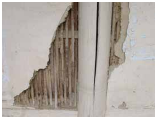
圖8 柱仔與穿仔間以竹條編製網狀，再抹上粗糠土填實，最後以白灰塗裝(南投鹿谷，2003年)(林宜君 攝)
