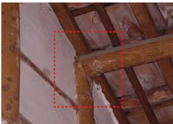
圖7 楹仔若未符合高度則必須在柱仔及楹仔下方使用竹片墊高，並以藤條(右圖：南投鹿谷，2003年)或鐵絲(左圖：高雄橋頭，2000年)綁繫固定(林宜君 攝)
