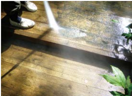
圖3. 福山林間步道以高壓水柱移除著生之蘚苔及藻類(許富蘭 攝)
